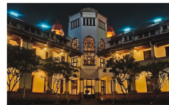
Bâtiment colonial Lawang Sewu à Semarang Photo: Visual Karsa
